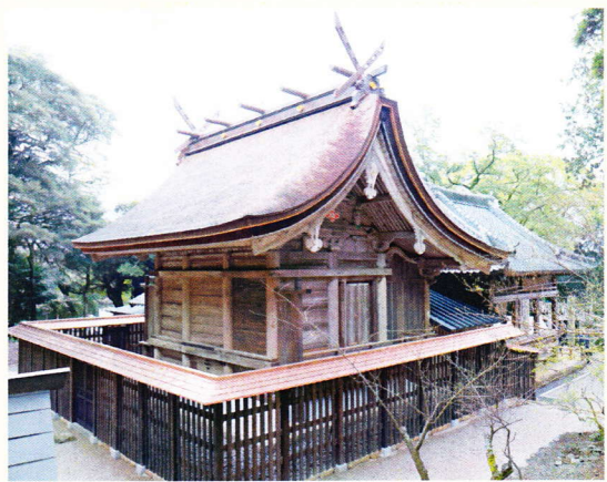
修復工事がなった高祖神社の全景
